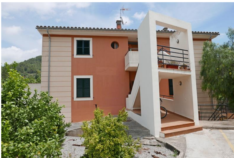
Foto 1. Vista de la fachada principal desde la calle de Ca l'Amet
