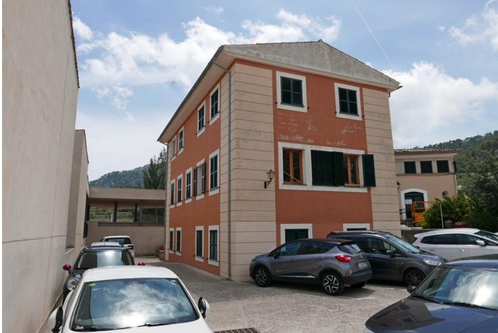
Foto 5. Zona donde se construye la ampliación
