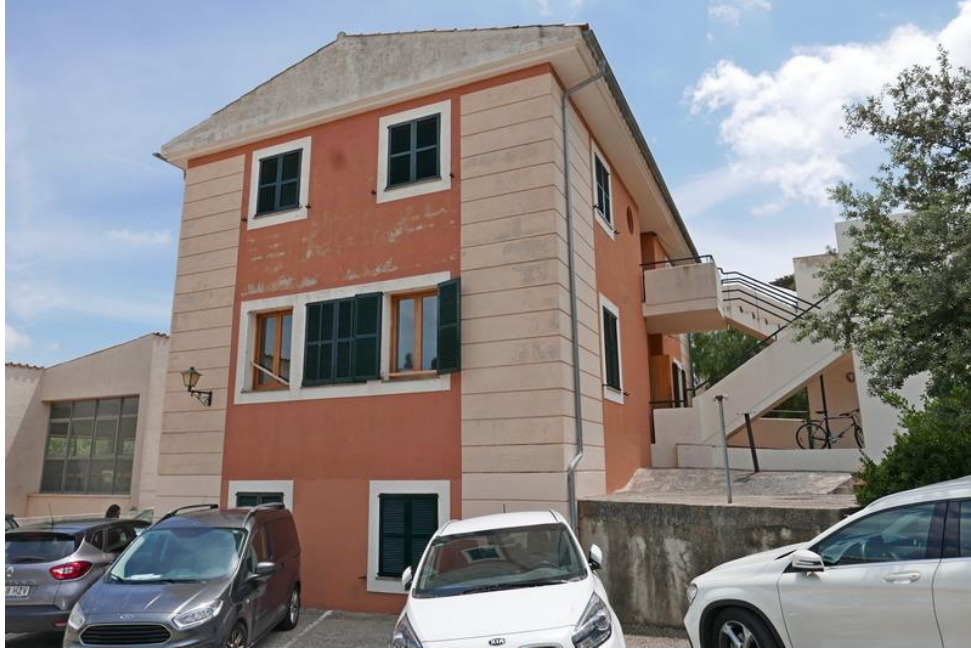
Foto 2. Vista de la fachada lateral desde el aparcamiento
